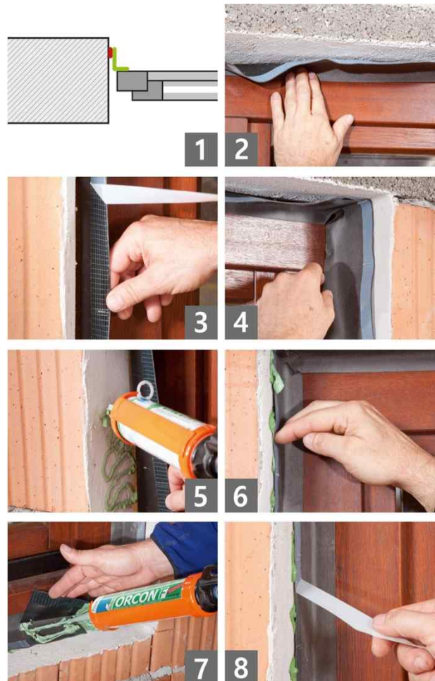
rc 창호 시공 후
