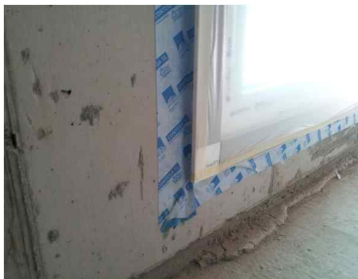
▲ 미장 작업 전
