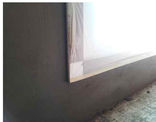
▲ 미장 작업 후
