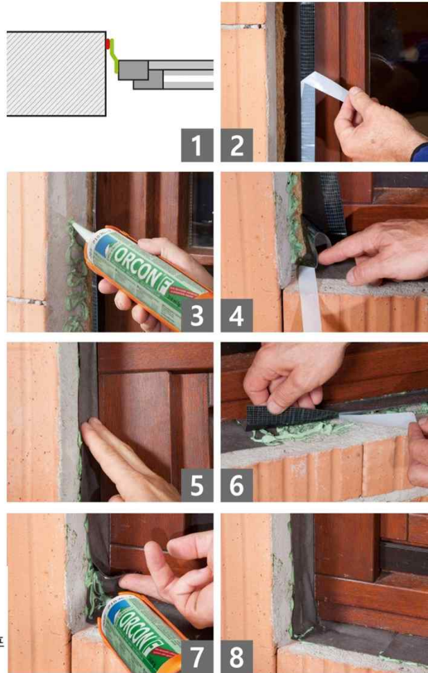
rc 창호 시공 전
