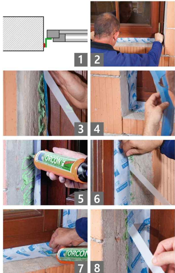
rc 창호 시공 후
