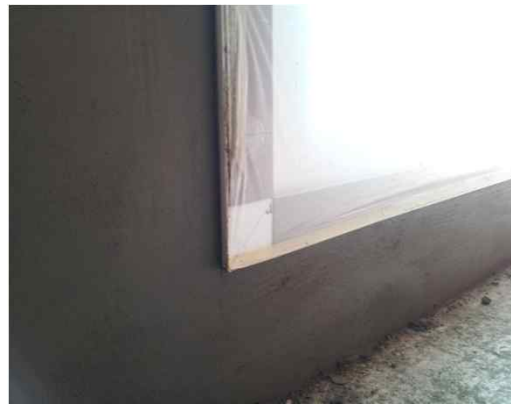
▲ 미장 작업 후
