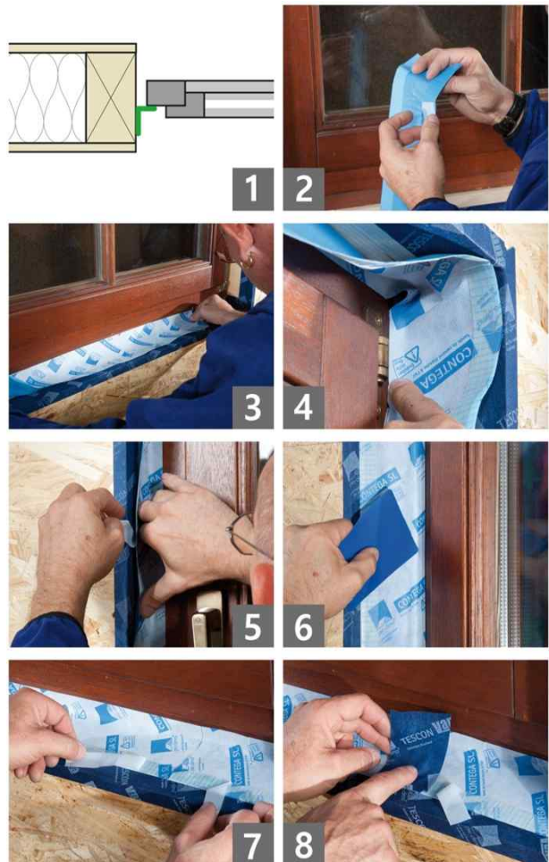
목재, 창호 시공 후
